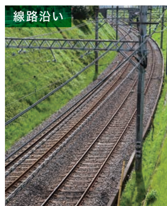
線路沿い 崖崩れや洪水の心配がある場所の警戒に。
